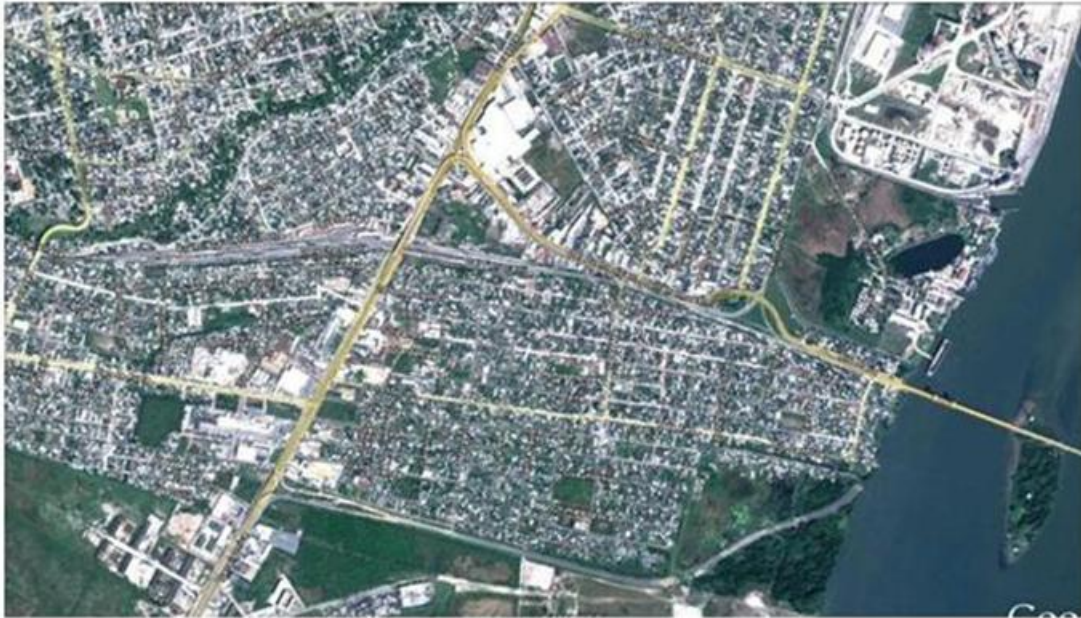
Figura II.2.2. Acceso carretero al Recinto Portuario de Coatzacoalcos. Fuente: Elaboración propia.
