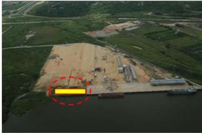
Figura IV.1.3. Sitio para la construcción de muelle marginal en el Recinto Portuario de Pajaritos, Etapa 2.
