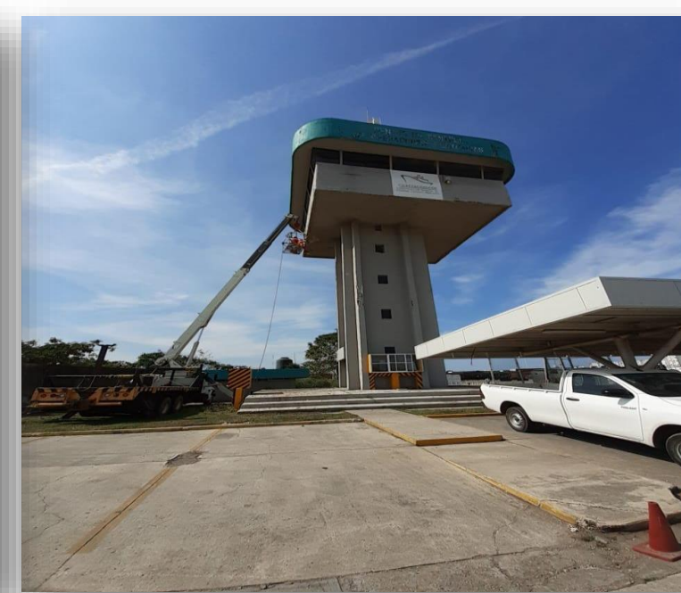
TORRE DE CONTROL
